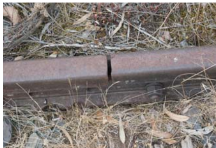
Junta de dilatação carris
