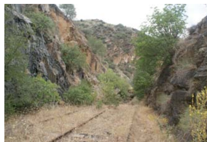
Derrocada na linha do Douro
