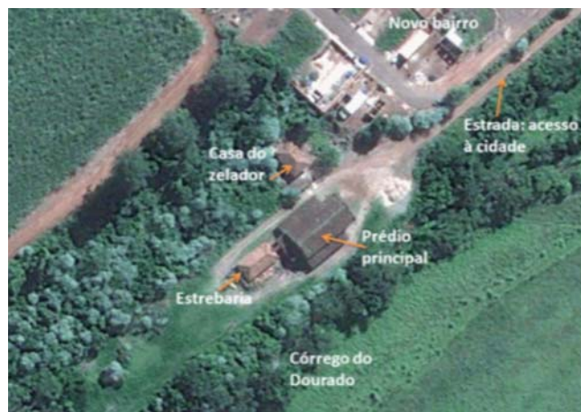
Os três edifícios do Matadouro Municipal de Dourado
