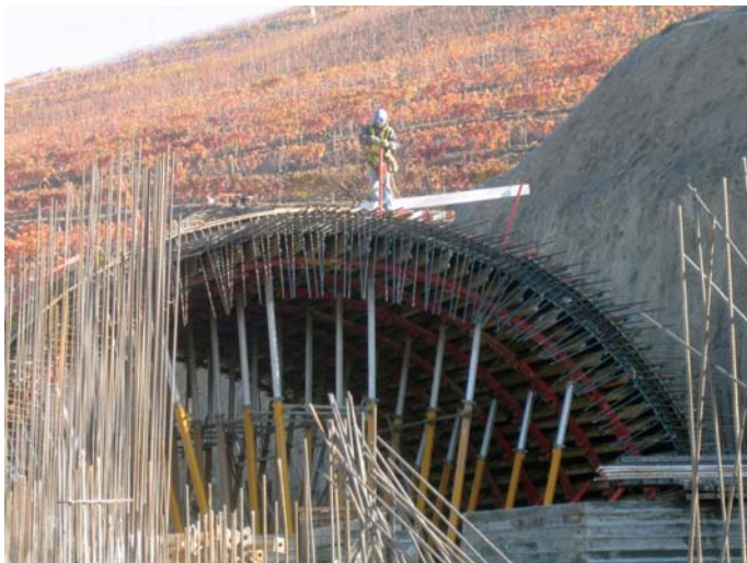
Processo de construção da Quinta do Vallado, 2008 Foto: Francisco Vieira de Campos
