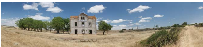
Estação de Hinojosa del Duero
