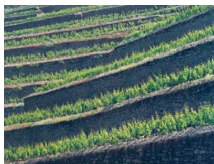
Terraços sustentados por muros de xisto
