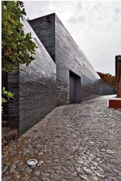
O edifício autonomiza-se e dialoga com a paisagem. Quinta do Vallado, 2010 Foto: Alberto Plácido ©
