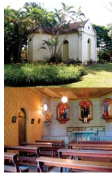
Capela da Fazenda da Mata, São João da Boa Vista, 2006.
